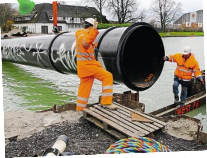
**RIESENRÖHRE:** Zwei 125 und 250 Tonnen schwere Autokräne versenkten am Dienstagmorgen ein 50 Meter langes Rohr in Höhe der ehemaligen Schillerbrücke. Durch den Stadthafen-Düker wird künftig die gesamte Abwasserableitung des östlichen Hansaviertels führen.
