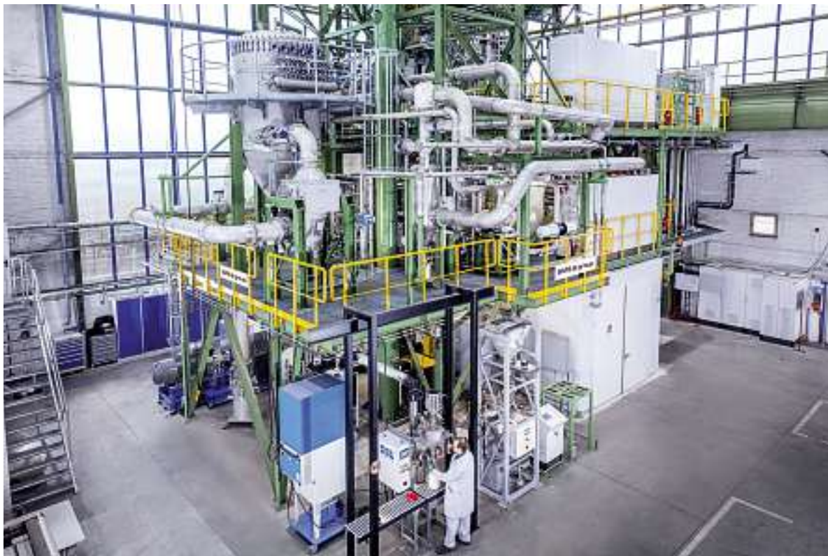
Die von der SMS group entwickelte und im eigenen Demo-Center betriebene Pulververdünsungsanlage dient zur Herstellung von hochwertigem Metallpulver für den 3D-Druck.
