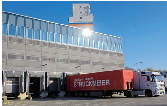
Unter anderem neue Verladerampen entstanden in Bottrop: MC-Bauchemie bekennt sich zu ihrem Hauptstandort. Foto: MC-Bauchemie
