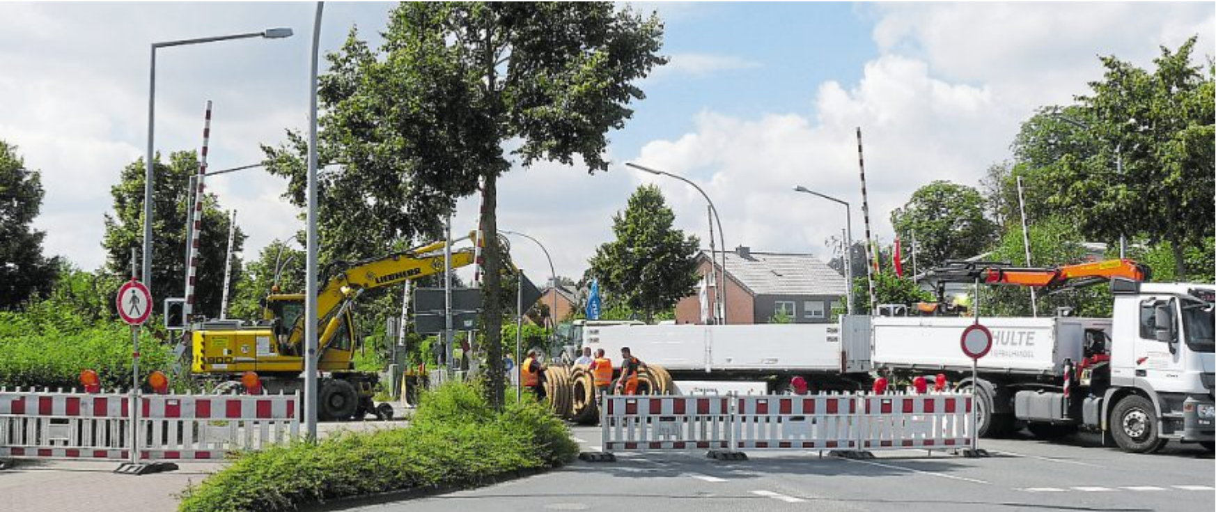
Der Bahnübergang Blumenstraße ist für Autofahrer, Radfahrer und Fußgänger voll gesperrt.
