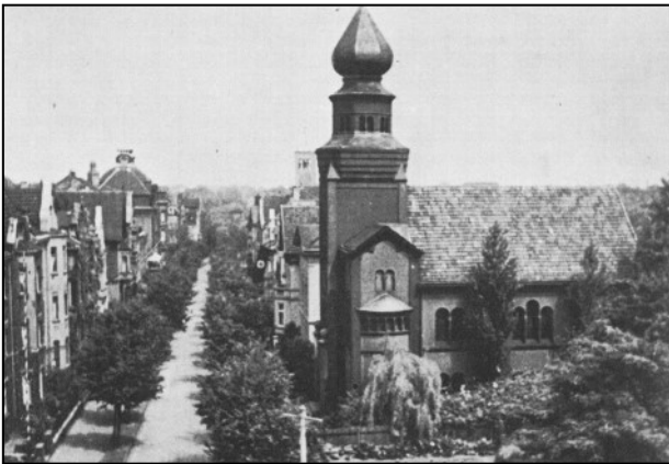
Jüdische Synagoge an der Limperstraße vor 1938
