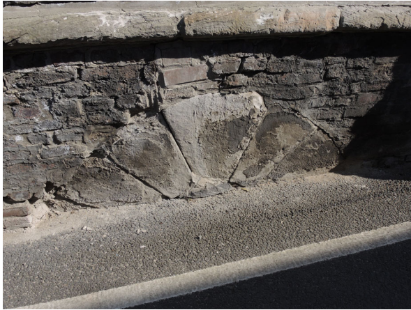
Abb. 6: Stollenmundloch von General Nr. 2 (T. KASIELKE).
