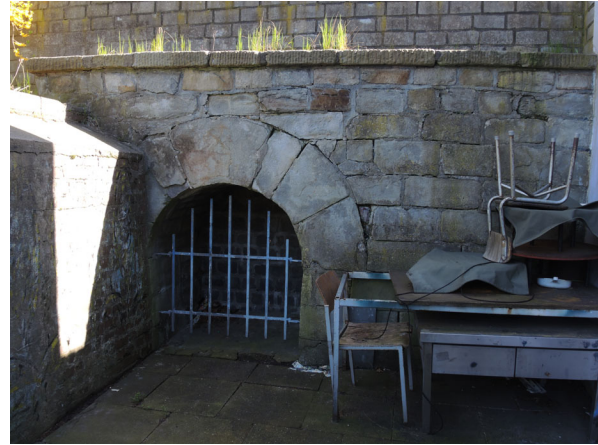
Abb. 7: Restauriertes Stollenmundloch von General Nr. 5 (T. KASIELKE).
