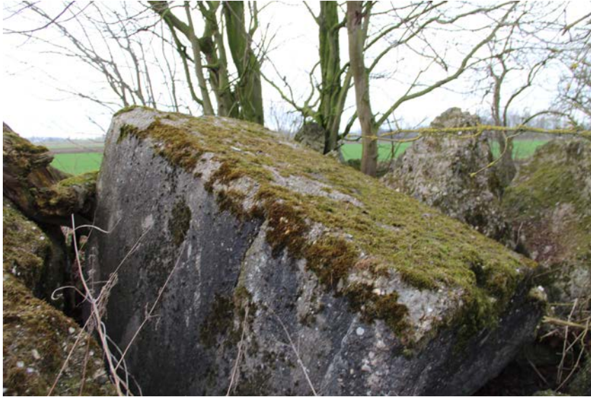
Bunkerreste heute an der Hammerstr. In der Nähe zur Kreuzung mit dem Immelweg
