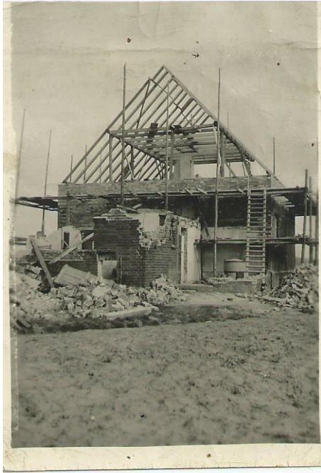
23.03.1944 Bombenschaden Wilhelm Soester, Werner Straße (B54), Wiederaufbau
