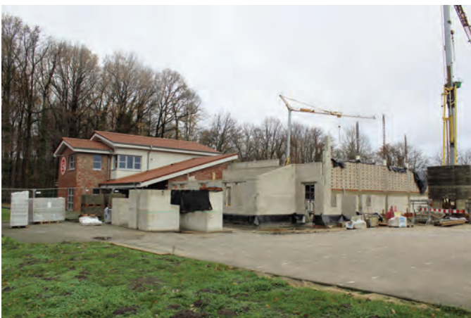
Neubau einer Schulsport- und Sportspielhalle in Füchtorf
