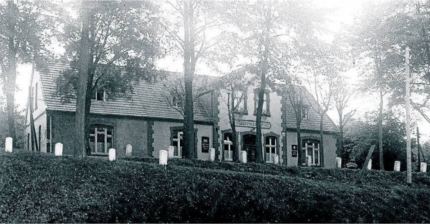
Die Gaststätte „Überwasser“ auf dem rechten Emsufer.
