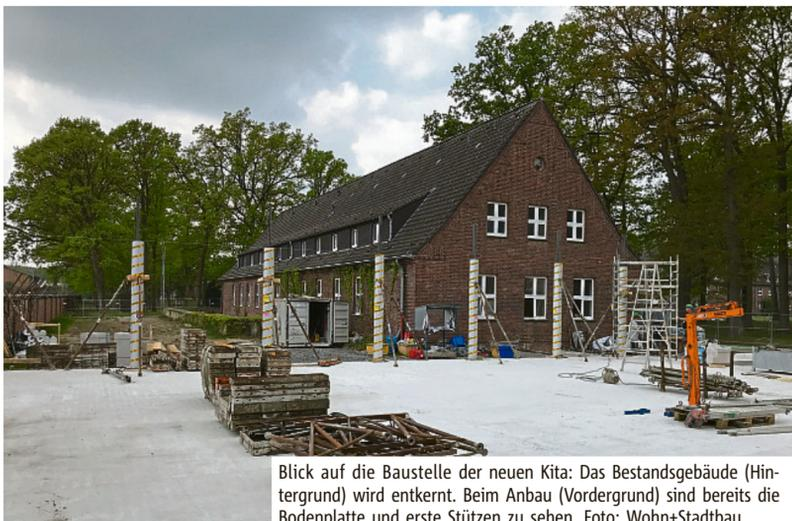
Blick auf die Baustelle der neuen Kita: Das Bestandsgebäude (Hintergrund) wird entkernt. Beim Anbau (Vordergrund) sind bereits die Bodenplatte und erste Stützen zu sehen. Foto: Wohn+Stadtbau
