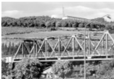
Kloster Maria Königin - im Vordergrund die alte Eisenbahnbrücke, heute Zufahrt zum Gewerbegebiet „Hundemaue“ und ins „Jammertal“
