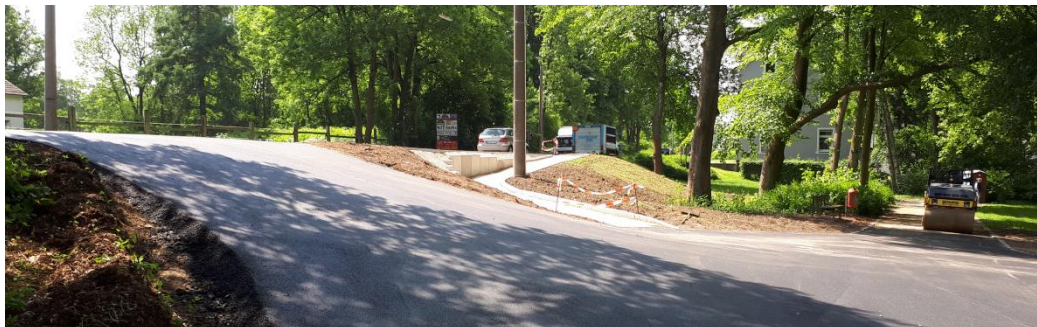
Bau einer behinderten- gerechten Rampe im Park am Brunnen
