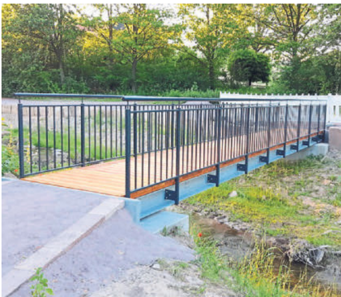
Die neue Brücke über den Kälberbach ist vor einigen Tagen in Germete montiert worden. Die Arbeiten zur Renaturierung des Gewässers sind weitgehend abgeschlossen.
