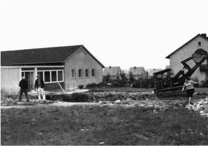
Langsam nimmt das Gelände Gestalt an (1958).
