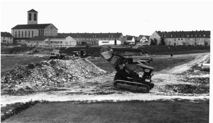
So fing es an: Beginn der Bauarbeiten 1957
