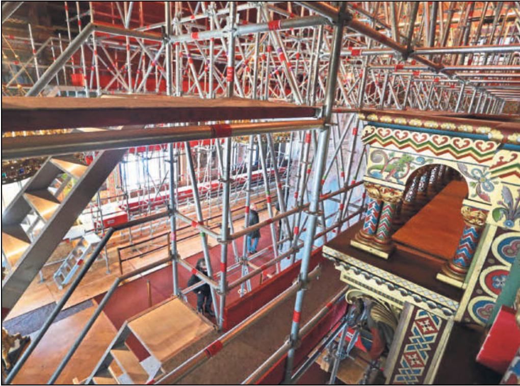
Eingerüstet ist der Sängersaal. Das Schloss wird für 20 Millionen Euro restauriert.
