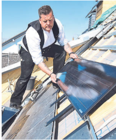
Einfach integriert: Solarelemente werden ins das Schieferdach-System flächendeckend eingelegt. Foto: Rathscheck
