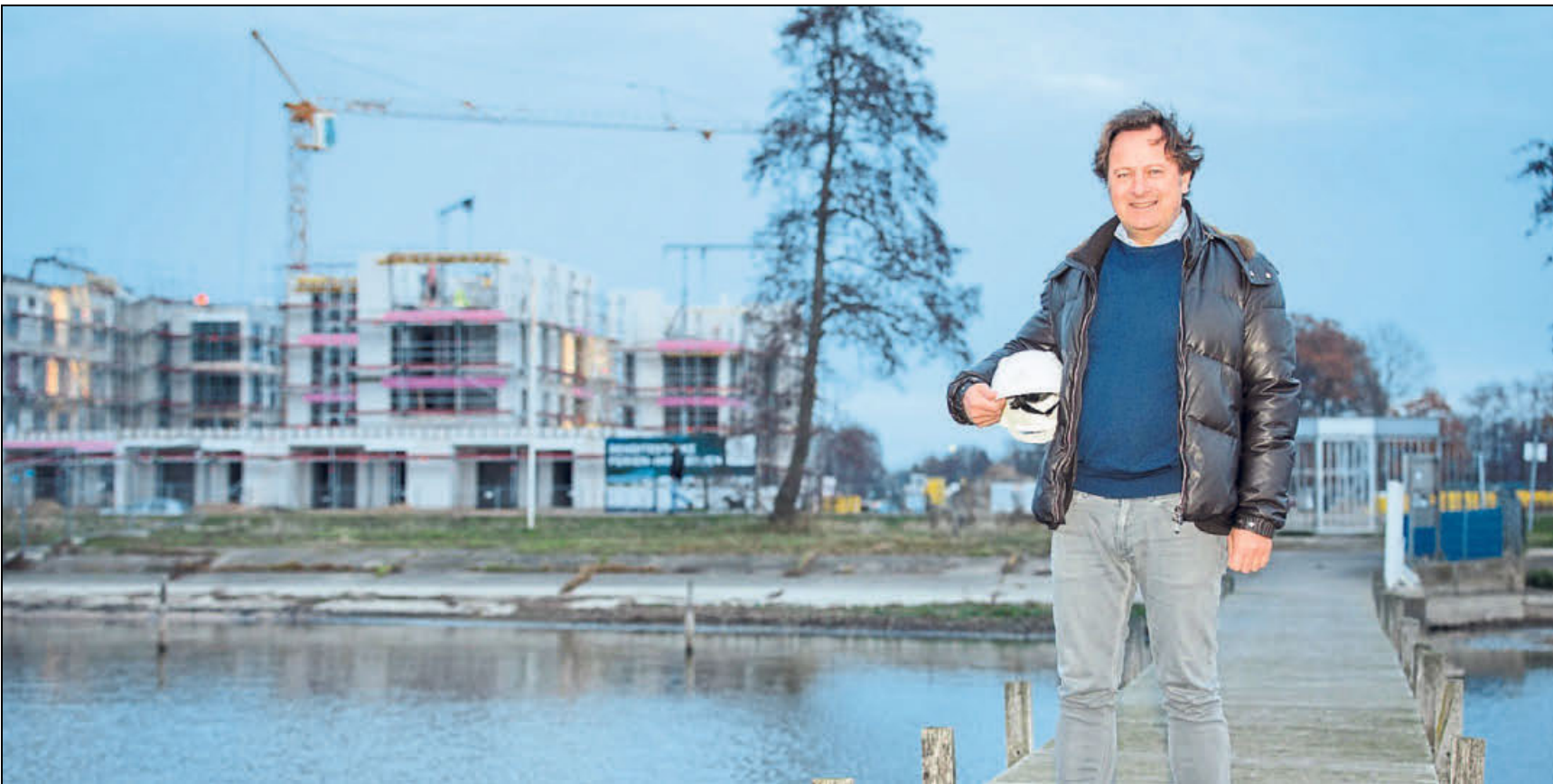
Ulrik Lundsryd auf der Baustelle des Marissa-Ferien-Resorts: Auf 18 Hektar entstehen am Ostufer des Dümmers Häuser und Wohnungen. Foto: avs
