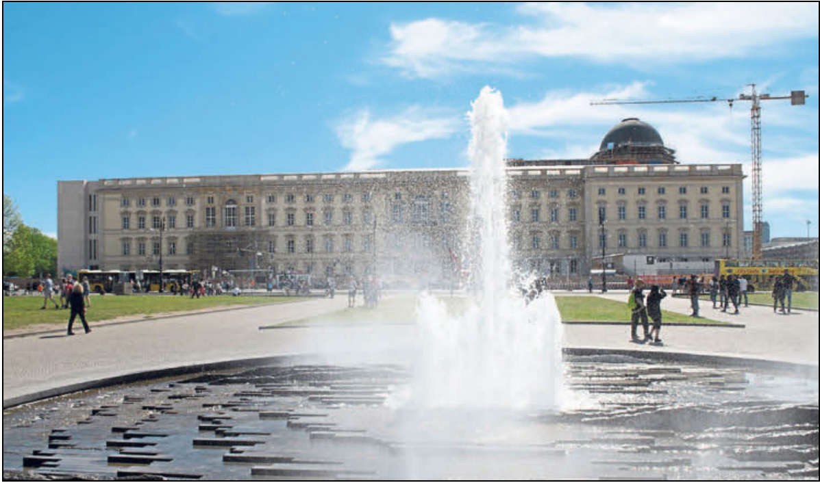
2019: Freie Sicht auf das neue Stadtschloss nachdem die Humboldt-Box abgebaut wurde.
