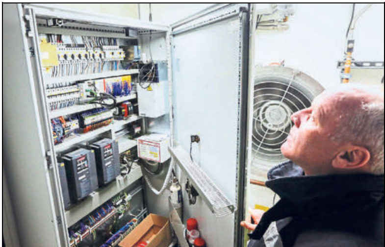
Mit Hilfe von Gas können die Ausbilder unterschiedlich starke Brände im Container simulieren. Moderne Technik macht's möglich.
