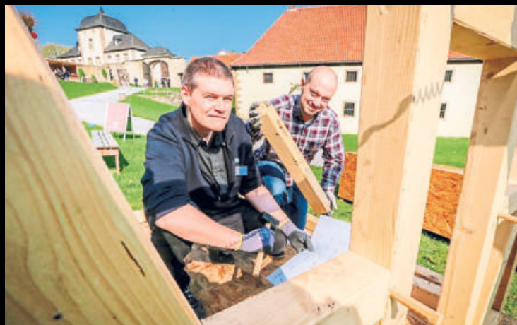
Die Tischler Ole Gerlach und Jan Kulücke zeigten, wie ein Fachwerkhaus aus Holz entsteht. Fotos: Jörn Hannemann
