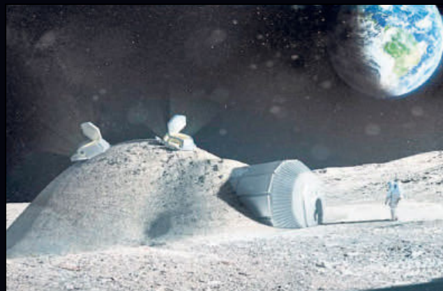
Das Modell einer möglichen Mondstation, die mittels 3-D-Drucker aus Mondgestein entstehen könnte.
