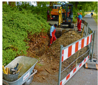
Wie in Höhe der Bismarckallee werden Stromanschlüsse verlegt. Foto: Stadt Münster
