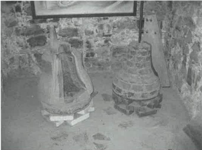
Das Formprinzip und die Hauptteile sind natürlich die gleichen: Der **Kern**, der dem Inneren der späteren Glocke entspricht, darauf die „**falsche Glocke**“, die herausgeräumt den Hohlraum für das einzugießende Metall ergibt, und der **Mantel**, die äußere, alles zusammenhaltende Glockenform. Auch das Material ist wie seit eh und je die Glockenbronze, eine Legierung von 22 Teilen Zinn und 78 Teilen Kupfer.
