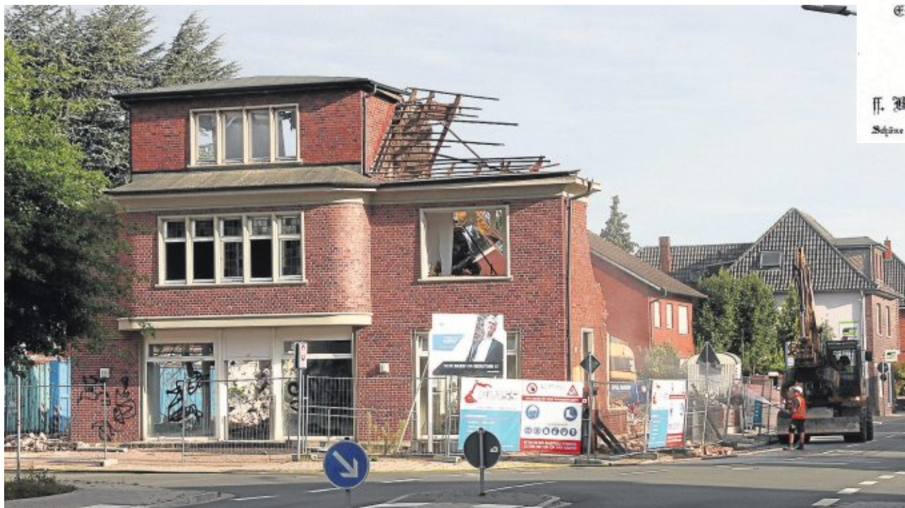
Die Abrissbagger „kanbberten“ im Juli am über 80 Jahre alten Gebäude der einstigen Gaststätte „Zum Zeus“.
