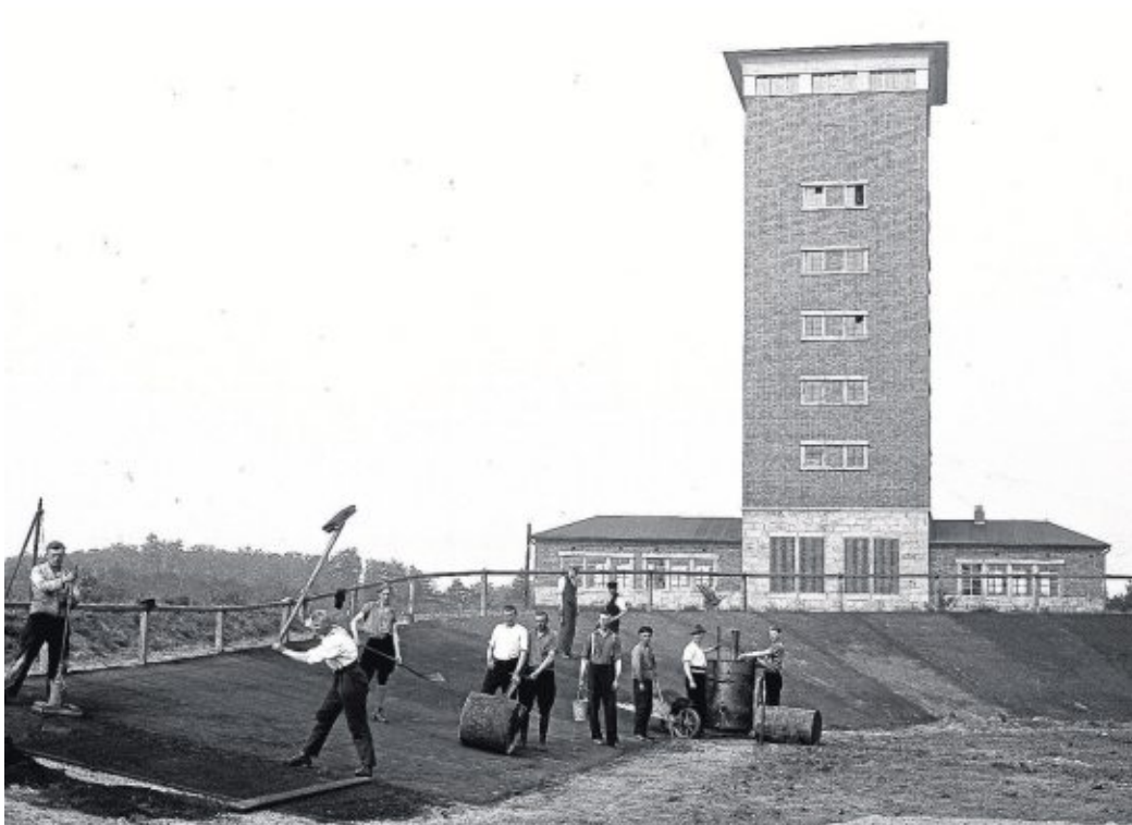
Der Wasserturm nach der Fertigstellung. Im Stadion gegenüber wird gerade die Radrennbahn gebaut.
