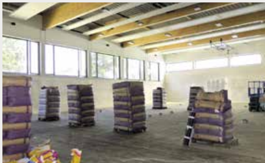
GS Hohenstaufenschule: Neubau Sporthalle
