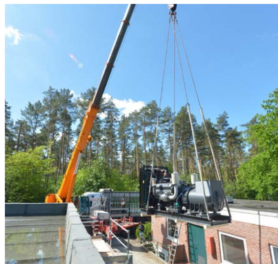
Alles andere als ein Leichtgewicht: Ende Mai wurde das neue Notstromaggregat mit einem Spezialkran gehoben ...
