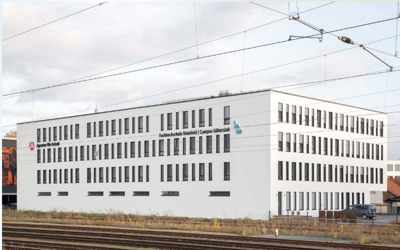
Wer am Bahnhof in Gütersloh aus dem Zug steigt, der sieht es sofort: das Gebäude mit dem Schriftzug »Fachhochschule Bielefeld« am Gleis 13.
