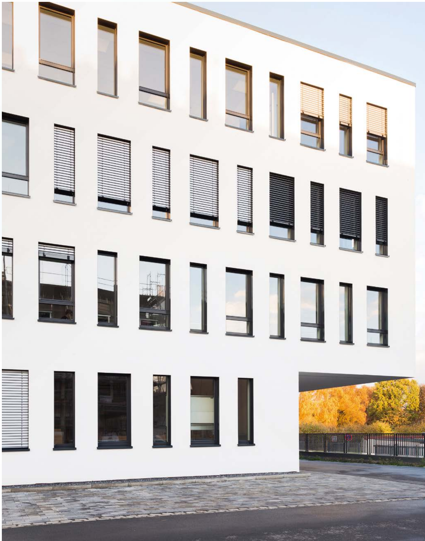
Der neue Standort des Fachbereichs Ingenieurwissenschaften und Mathematik der FH Bielefeld in Gütersloh: Haus III am Gleis 13 am Langen Weg.
