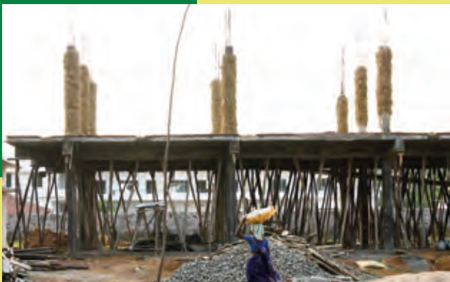
Die Baustelle der Sonderschule mitte Februar
