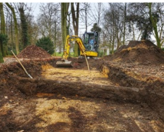
Für den Spielplatz wurden aufwendige Erdarbeiten durchgeführt.
