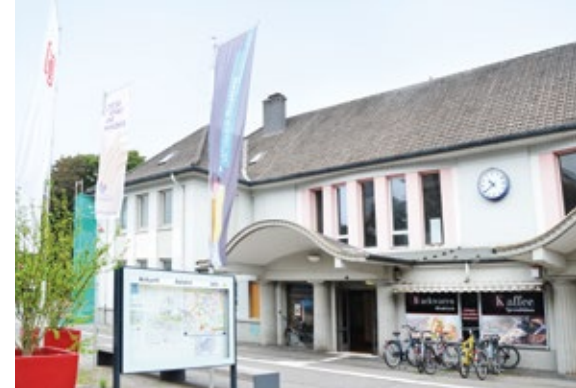
Auch die Fassade des Bahnhofs wird erneuert.
