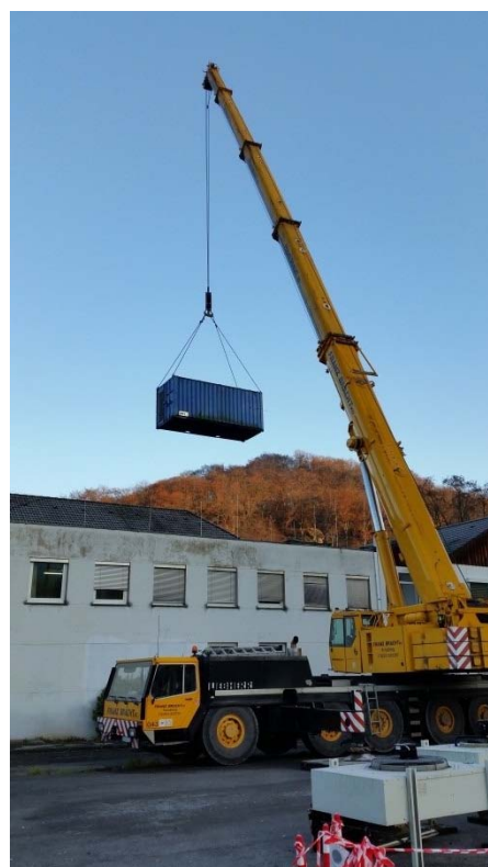
Demontage des Netzersatzaggregates (NEA) am alten Standort Langenkampstr. 33 im Dezember 2018
