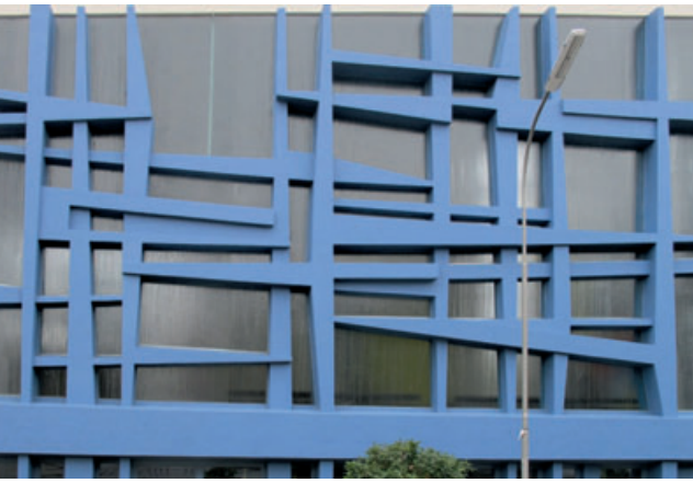
10 Südwand mit der Glasgestaltung von Thierry Boissel von außen, 2018.
