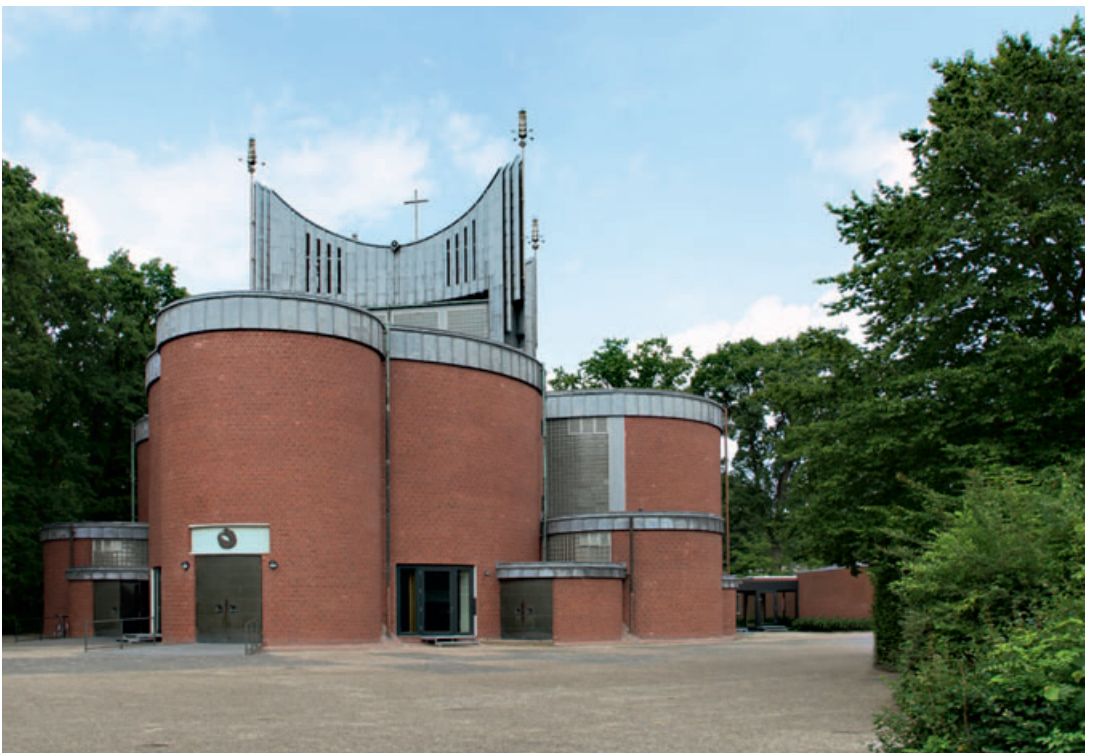
6 Außenansicht der ehemaligen Kirche 2017.
