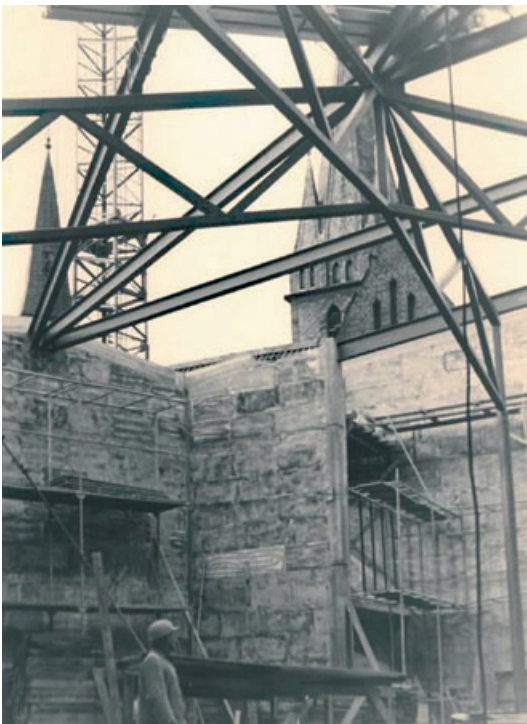
14 Baustelle nach Montage der Stahlträger mit Blick auf den Kirchturm des Vorgängerbau, undatiert (1967?).
