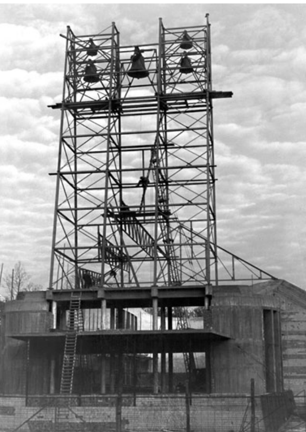
4 Raumfachwerkkonstruktion des Turmes und Betongusswände, zwischen 1963 und 1966.
