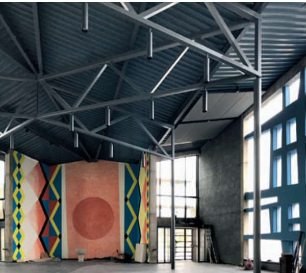
16 Blick in den Kirchenraum im September 2018 während der Bauarbeiten mit Taufstein am alten Standort und Muster der Akustikplatten an der Unterseite der Decke. Die Farbfassung der Westwand wurde später noch einmal überarbeitet.
