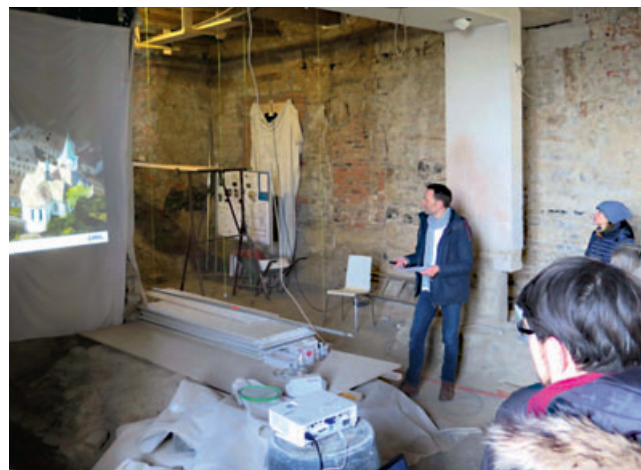
Vortrag von Knut Stegmann auf der aktuellen Baustelle im Prämonstratenserchorherrenstift Wedinghausen.
