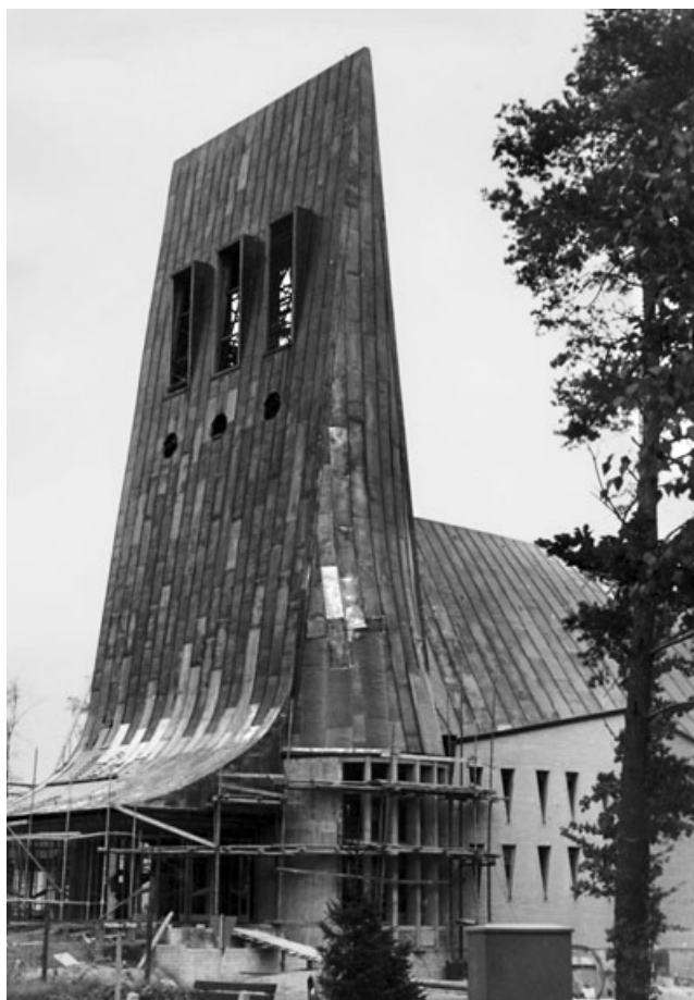
5 Raumfachwerkkonstruktion mit Kupferverkleidung, zwischen 1963 und 1966.
