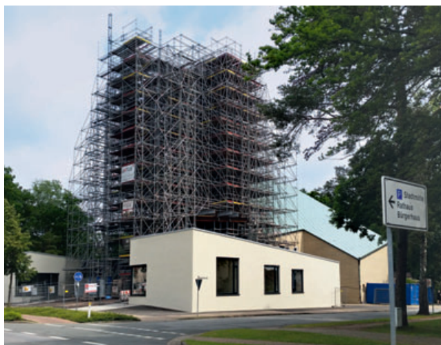
10 Reparatur des Turmes nach dem Brand 2019.
