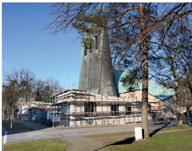
9 Errichtung des neuen Gemeindezentrums. 2017.
