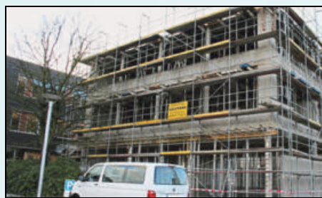
Im Frühsommer war der Rohbau schon fast fertig.
