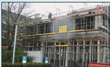
Anfang des Jahres standen das Erdgeschoss und die erste Etage.
