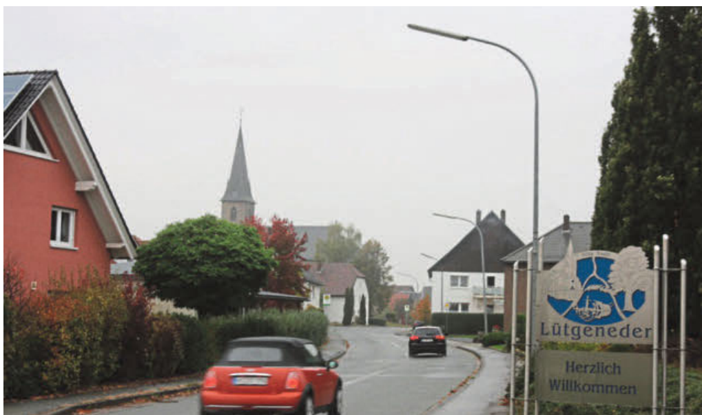
Die Straßenbeleuchtung in Lütgeneder (Foto), Großeneder, Natungen, Borgholz und Drankhausen wird bis Anfang 2020 auf LED-Technik umgerüstet. Die Lichtmasten erhalten neue LED-Köpfe. Ausgetauscht werden 476 Leuchten.
