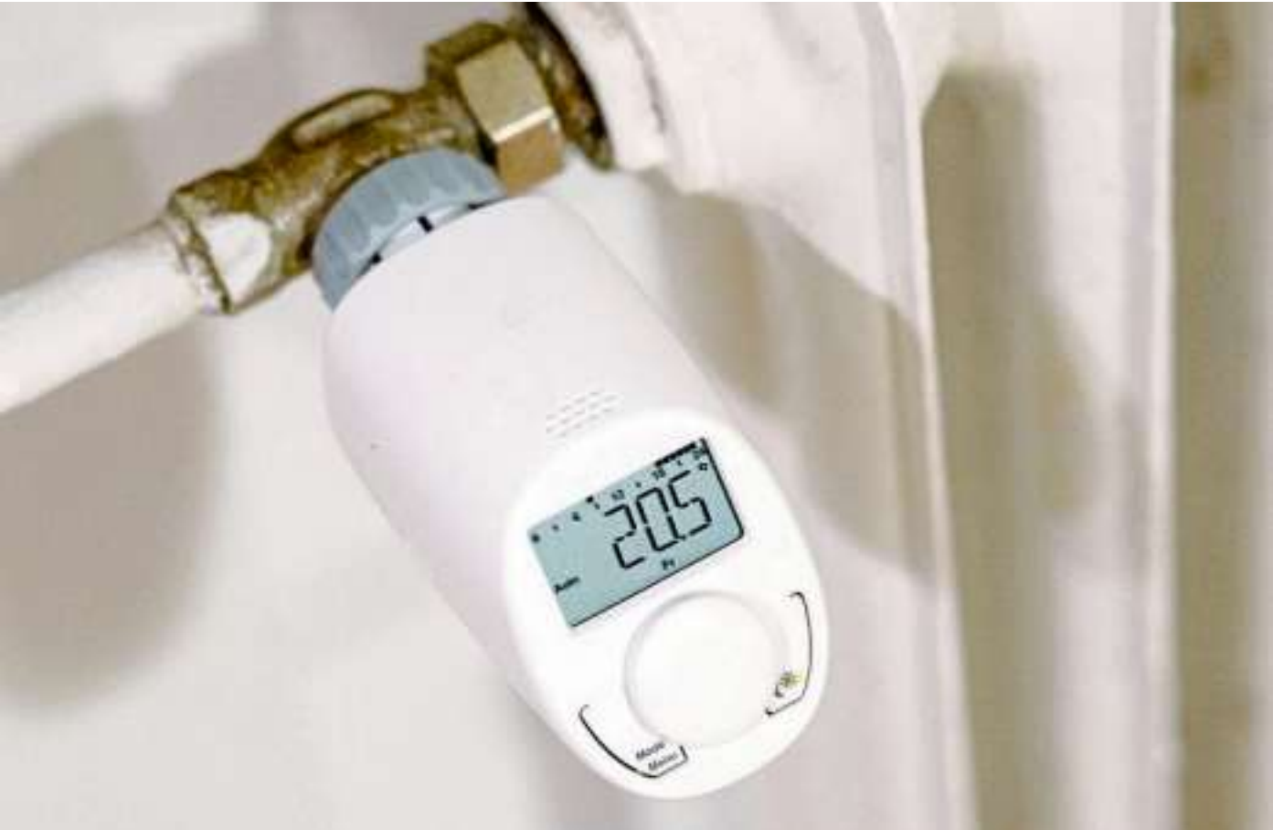
Das kann Heizkosten sparen: An digitalen Thermostaten lassen sich die erstrebten Raumtemperaturen exakt einstellen. Foto: dpa/Karolin Krämer
