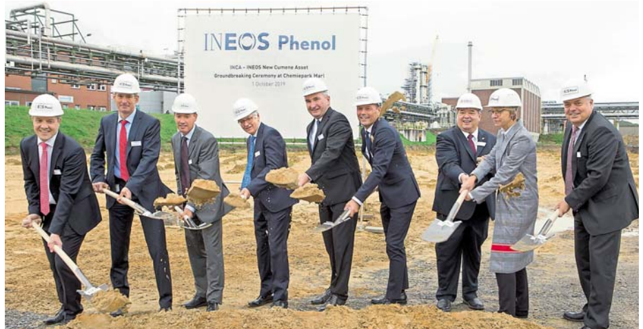
Spatenstich im Chemiepark Marl: Anfang Oktober gab Ineos Phenol das Startsignal für den Bau einer neuen Produktionsanlage für Cumol.
