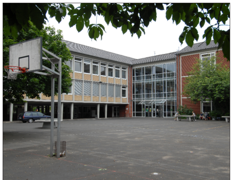
Wertvolle Ergänzung der Uni-Immobilien könnte das Stein-Gymnasium am Hindenburg-Platz werden. Foto: Peter Grewer
