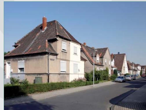
Gefahr der Einzelprivatisierung: un-abgestimmte Renovierungen.
