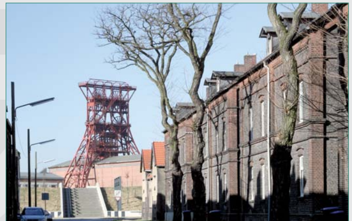
Die Siedlung Erdbrüggenstraße und die alten Robinien zusammen mit dem Fördergerüst von Consol 9.
