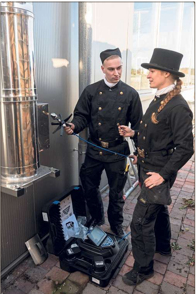
Justin Otto kontrolliert das Abgasrohr einer Scheitholz-Heizung mit einer Endoskop-Kamera – unter Aufsicht seiner Ausbilderin, Schornsteinfegermeisterin Josephine Villmann. Bild: dpa
