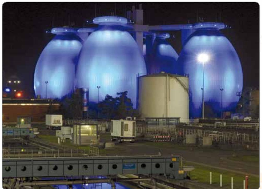
*Auf der Kläranlage der Emschergenossenschaft werden jährlich 15,5 GWh Strom aus Faulgasen erzeugt.*
