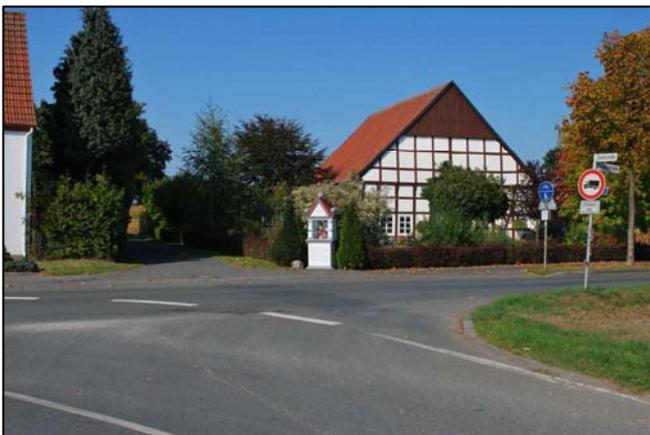
**Vierständerrachwerkgebäude am Ortsrand mit verputzten Gefachen, Verbretterung der Giebelspitze, roter Dacheindeckung und aufgeklebten Sprossen.**
