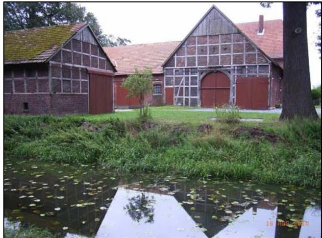
**Vierständerlängsdeelenfachwerkhaus mit T-förmigem Stall- und Scheunenanbau und einer Fachwerkscheune. Die Gefache sind ausgemauert, die Giebelspitze verbrettert und das Deelentor ist noch mit den Torbogenverzierungen vorhanden.**
