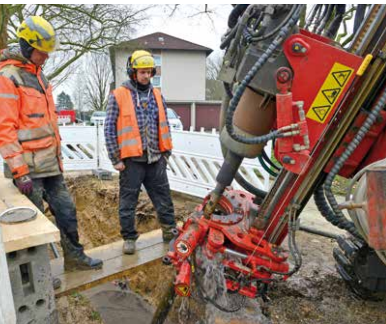
Michael Mazalla und Daniel Grunert machen Testbohrungen am Bommerfelder Ring wegen des Verdachts von Bergbauschäden. Foto und Text: Barbara Zabka
