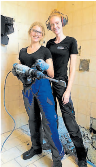
Volle Kraft voraus: Sarah Liedtke und Sandra Hunke im Einsatz auf der Baustelle.
