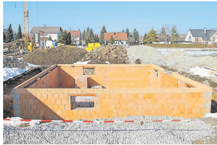
Ein Keller bietet viel Platz und ist beim Hausbau eine attraktive Möglichkeit. Damit der Keller aber nicht zu einem modrigen Raum verkommt, ist die Wahl des richtigen Wandbaustoffs wichtig. Der massive Baustoff Ziegel ermöglicht einen guten Wärmeschutz, sodass die Kellerluft gut zirkulieren kann, das Raumklima ausgewogen und die Luft gesund bleibt.
