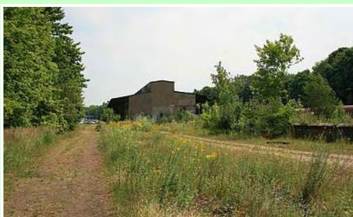
Blick von Norden in Richtung Empfangsgebäude
