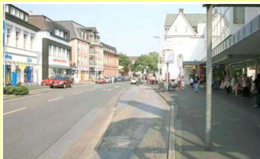
Erweiterung Unnaer Straße
