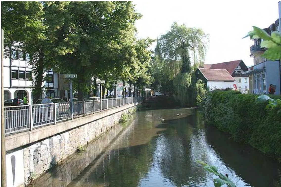
Der Mühlengraben im Bereich der Bahnhofstraße - Bestandssituation
