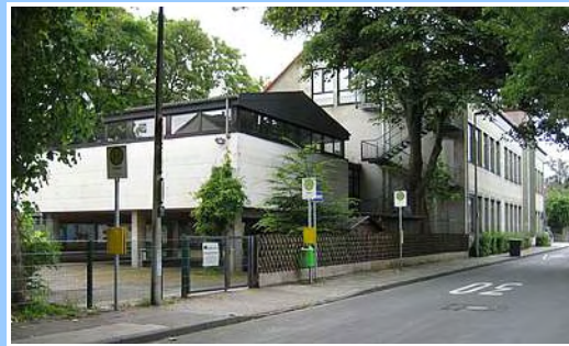
Ansicht von der Papenhausenstraße
