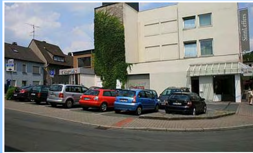
Der vorhandene Parkplatz neben dem Gebäude
