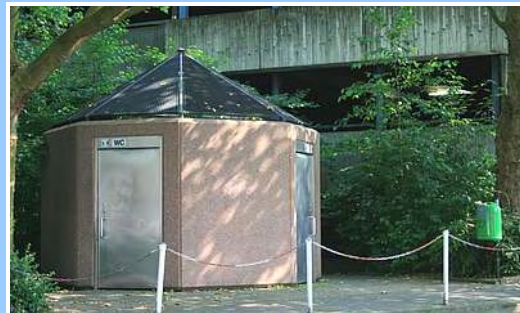
Vorhandene Toilettenanlage am Parkhaus Nordwall
