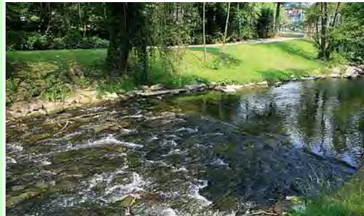
Vorhandenes Ufer im Bereich der kleinen Hönneinsel
