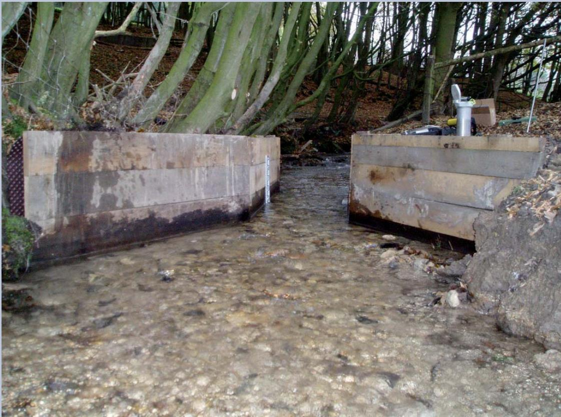
Bild 3: Neue Pegelanlage an der Olvecke in Leihbach / Büren
