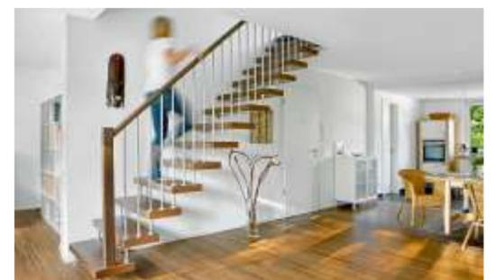
Der aktuellen DIN-Norm entsprechend empfiehlt der Treppen-Spezialist Kenngott ergonomische Rundhandläufe zum sicheren Umgreifen. Foto: epr/Kenngott
