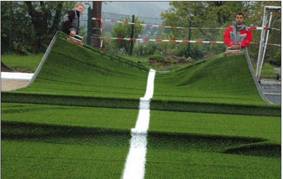
In großen Bahnen wurde der neue Kunstrasenbelag ausgelegt. Anschließend wurden diese Bahnen miteinander verklebt.
