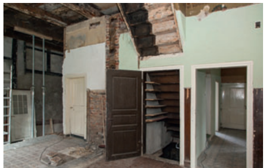
7 Der ehemalige Küchenraum während der Bauphase; gut zu erkennen sind die Spuren der ehemaligen Kamine.
