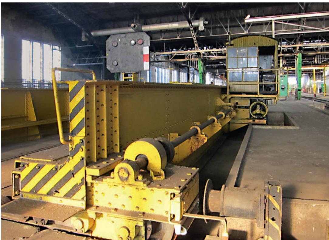
8 Detail der Schiebebühne, Foto von 2017.
