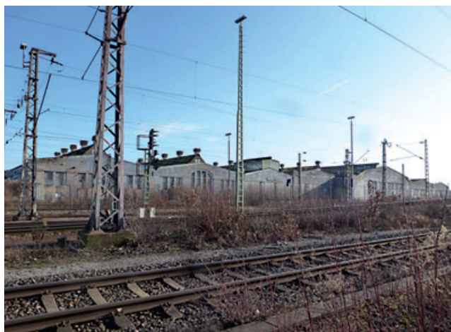
3 Westansicht des Personenzuglokschuppens von 2017.
