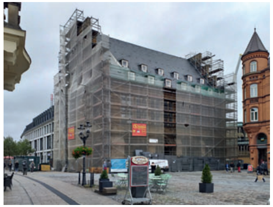
3 Blick vom Marktplatz auf das eingerüstete historische Rathaus. Links daneben am Scharn das neue Büro- und Geschäftshaus, Ende 2019.
