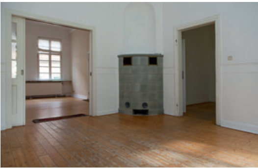
6 Blick in die Wohnräume im Erdgeschoss vor der Sanierung 2014; in die bauzeitlichen Ofennische wurde um 1930 ein Kachelofen eingebaut.
