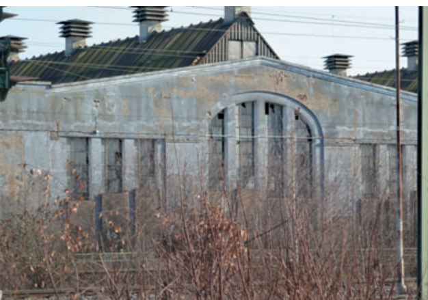
6 Fassadenausschnitt des Personenzuglokschuppens, Foto von 2017.
