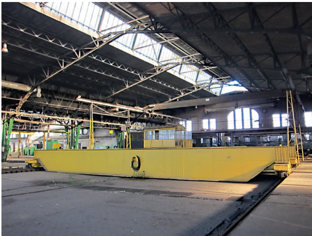
4 Innenansicht des Personenzuglokschuppens mit Schiebebühne von 2017.
