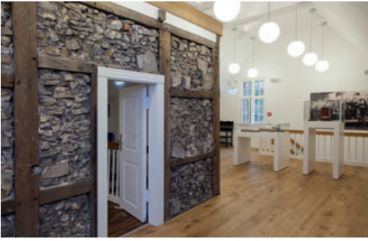
5 Der ehemalige Bodenraum im Dachgeschoss nach Fertigstellung des Museums. In der Fachwerkwand links im Bild wurden die Bruchsteinfüllungen exemplarisch erhalten.
