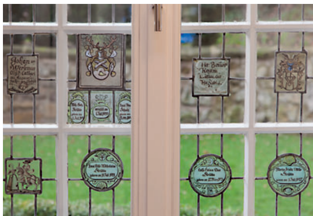
2 Ausschnitt aus dem Fenster in der ehemaligen Küche (Blick in den Garten) mit den eingesetzten kleinen, bemalten Scheiben, den sogenannten Fensterbierscheiben. Zustand nach der Restaurierung 2015.
