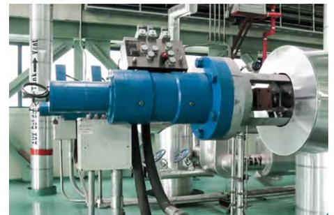
Hydraulikantrieb für Turbinen-Bypass-Ventil, mit Regelfunktion über Proportionalventil und 3-fach Sicherheitsauslösung der Schnellöffnungsfunktion.
