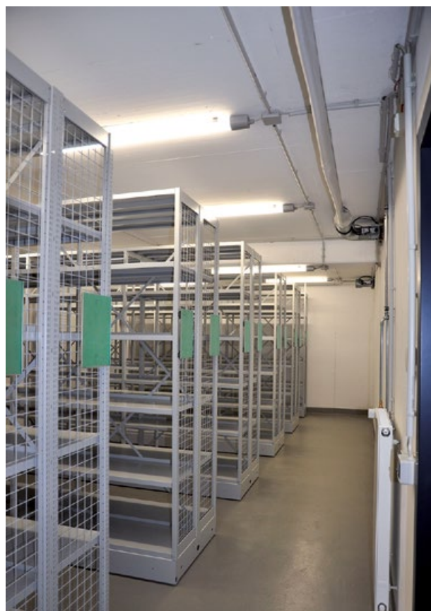
Das Quarantänemagazin im Untergeschoss des Neubaus. An der Decke ist der Textilschlauch der Zuluft erkennbar. (Foto: LWL-Archivamt)
