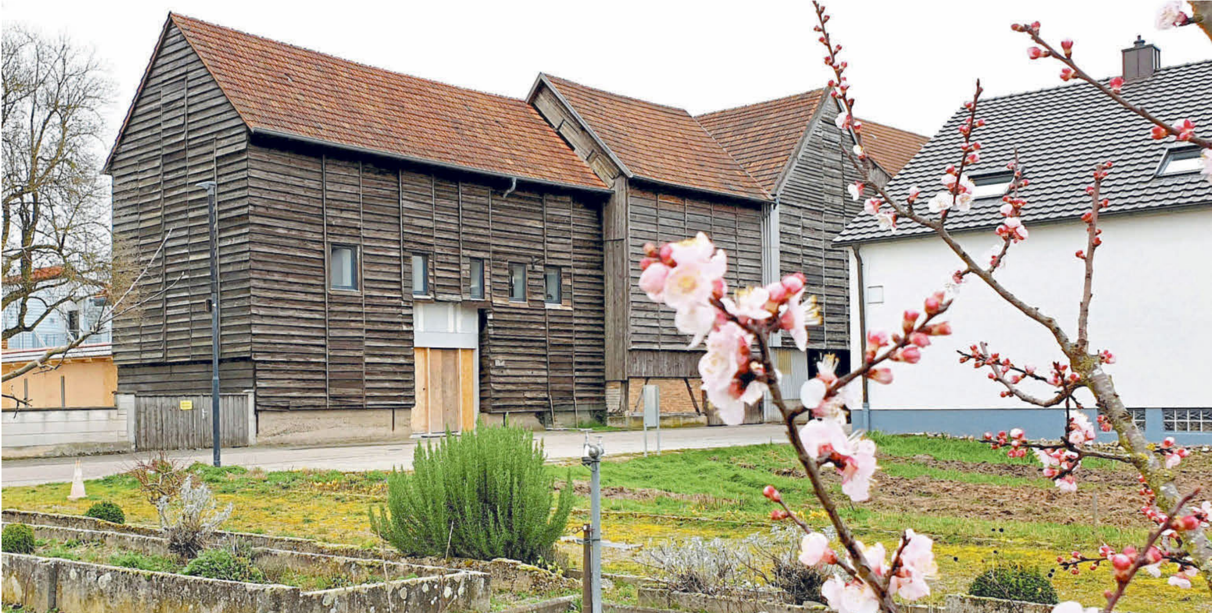
Anbau an die Höfe: Dieser Tabakschuppen befindet sich an der Hauptstraße in Herxheim-Hayna.
